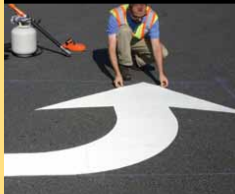
Placer le produit PreMark® selon le plan établi.
