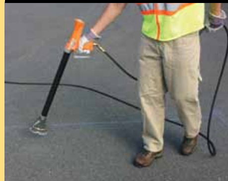
Nettoyer la surface pour en enlever toute trace d'humidité.
